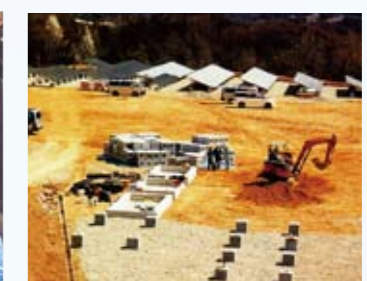
発電土木工事
