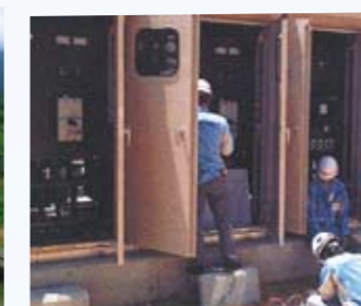
発電設備工事
