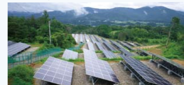
中津川発電所
